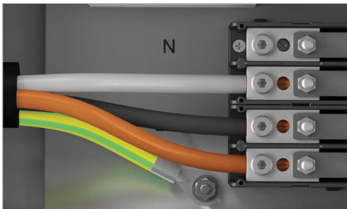
Ejemplo de conexión de 3 fases + PE
