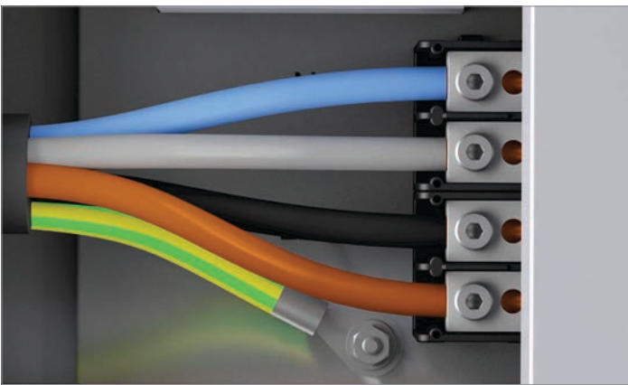
Exemples de raccordement 3 phases + N + PE
