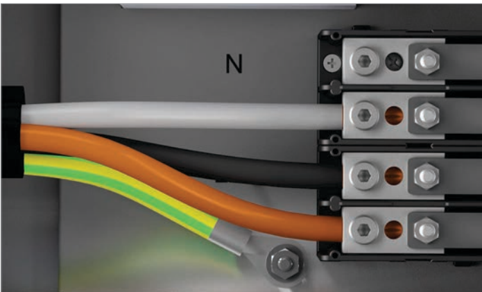
Exemple de raccordement 3 phases + PE
