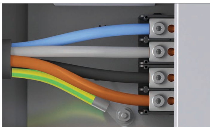
Aansluitvoorbeeld 3 fasen + N + PE
